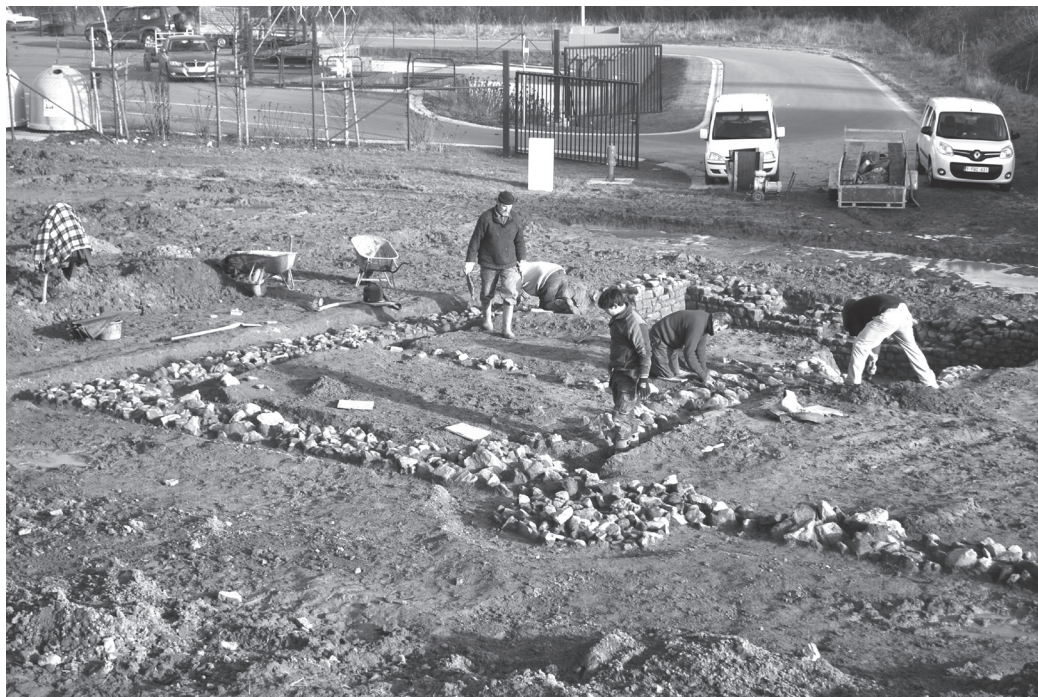
Fig. 1. Dégagement des fondations du bâtiment (photo D. Henrotay).
